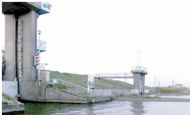
ダム・河口堰等の水位観測
