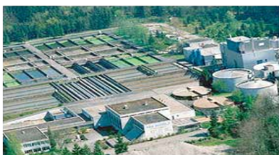
上下水・浄水関連施設で水位監視
